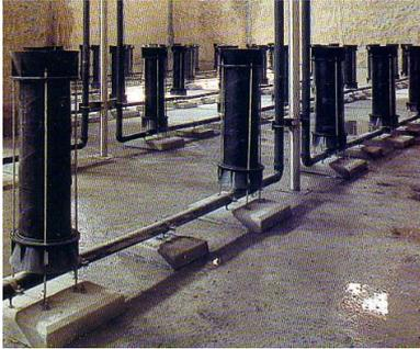
**Diffusore Statico Aerobico Jet-Helix : apparecchio a 5 Elementi**
